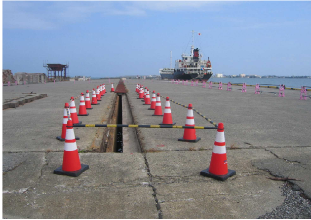
施行現場の状況
