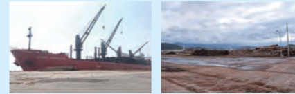
津田地区岸壁
