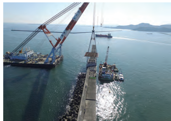
ケーソン据付
