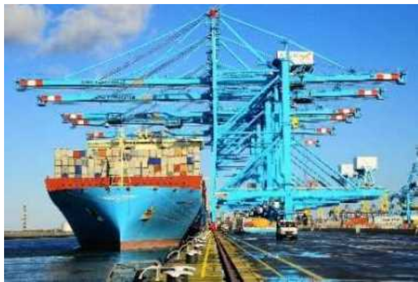
①ガントリークレーンがコンテナを積卸
