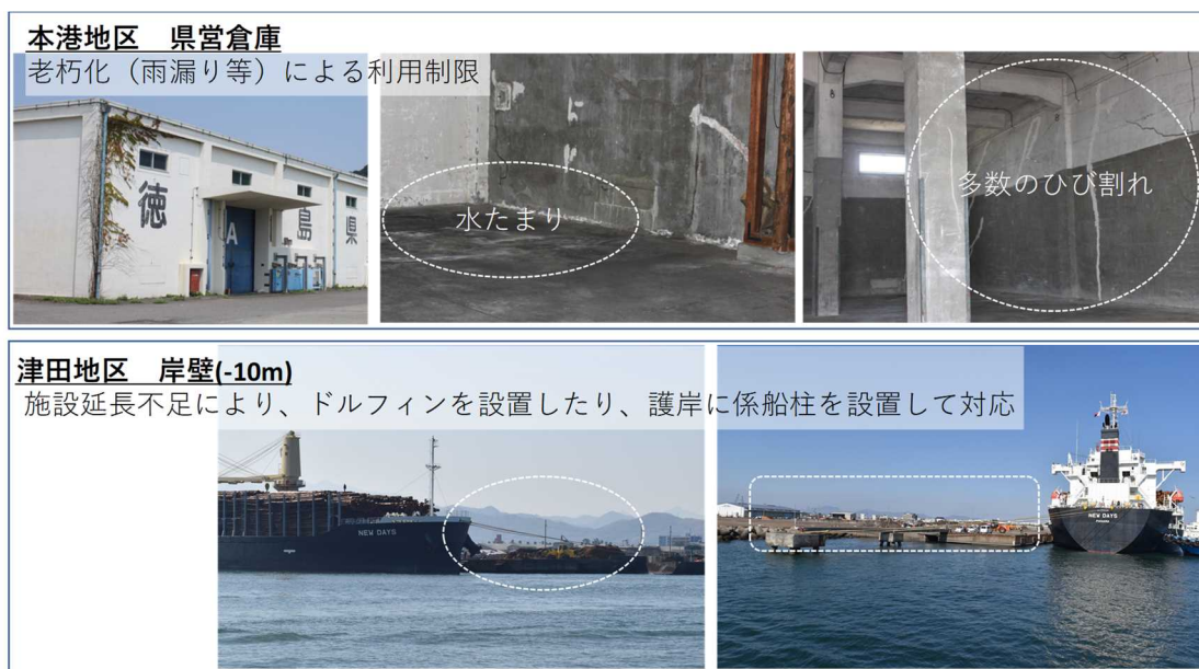
図 2.6 上：本港地区県営倉庫、下：津田地区岸壁
