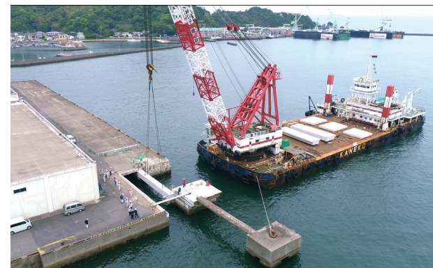
岸壁渡版の据え付け状況(令和3年5月)
