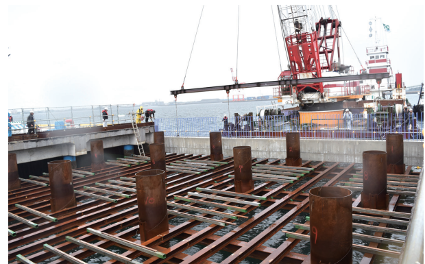
ブロック設置状況(平成30年12月時点)
