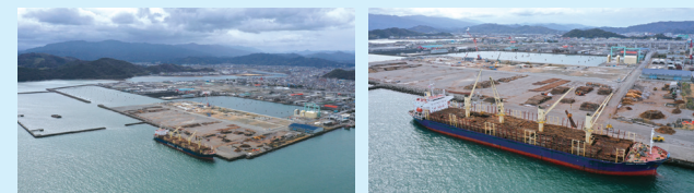
津田地区岸壁
