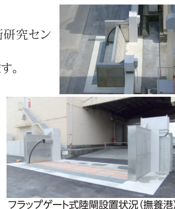
フラップゲート式陸閘設置状況（撫養港）
