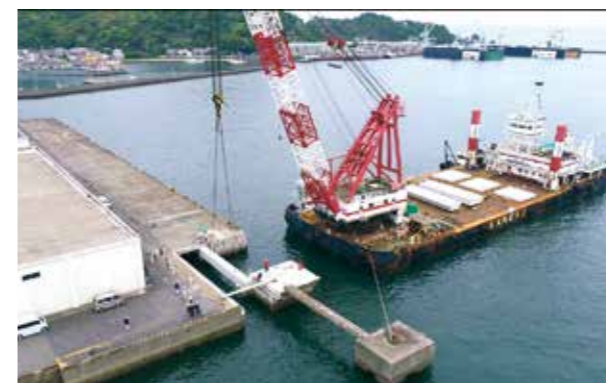
岸壁渡版の据え付け状況(令和3年5月)
