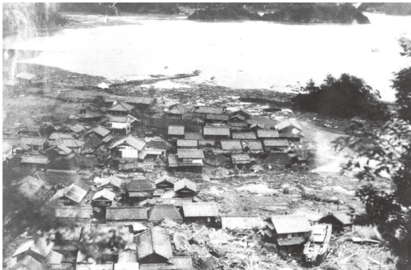
【昭和南海地震(昭和21年)による浅川港(海陽町)の被災状況】地震により発生した津波のため、集落が壊滅的な被害を受けた。
