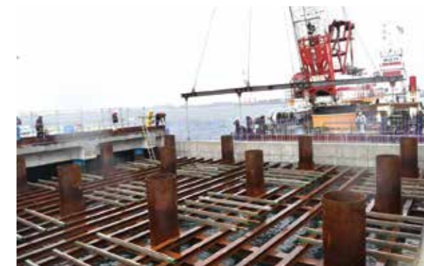
ブロック設置状況(平成30年12月時点)
