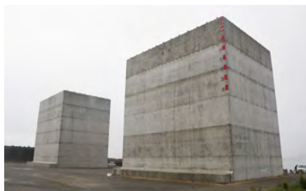
据付予定のケーソン2函 (B11.6m×L15.9m×H15.7m)
