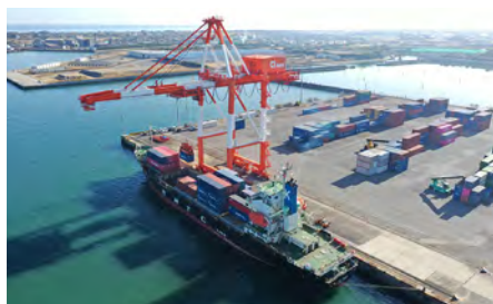
現在の赤石地区ガントリークレーン (新たに1基を設置予定)
