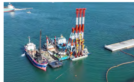
令和7年度実施の地盤改良工事 (サンドコンパクションパイル工法)
