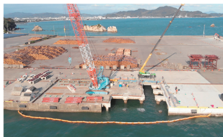
工事の様子 (令和2年3月撮影)
