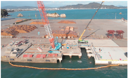
工事の様子 (令和2年3月撮影)
