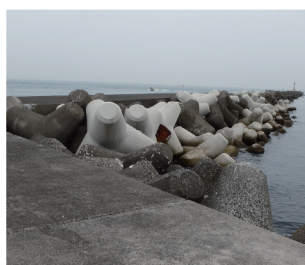
消波工機能復旧状況(令和6年4月撮影) 津田地区防波堤
