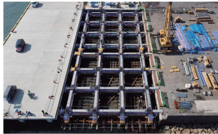
工事の様子 (令和5年10月撮影)
