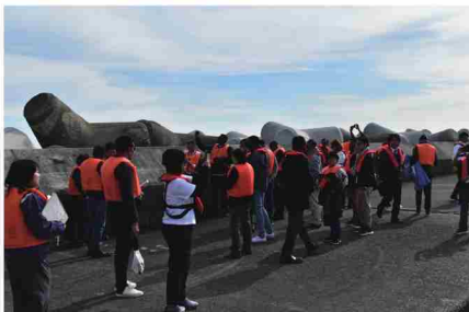
消波ブロックの沈下が発生した箇所 新しいブロックを積増した箇所を見学
