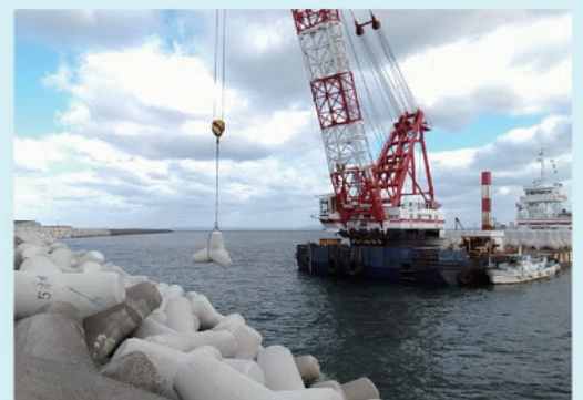
消波ブロック(16トン)の設置状況 (沖洲(外)防波堤)
