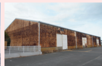
新港地区の老朽化した倉庫
