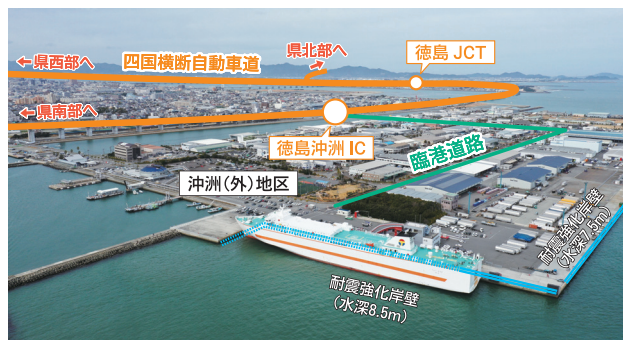
沖洲(外)地区耐震強化岸壁と背後道路状況
