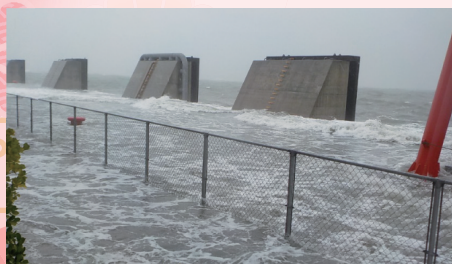
2018年台風第21号により浸水した 沖洲のフェリーターミナル
