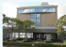
移転先の「小松島みなと合同庁舎」
