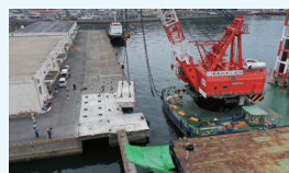
起重機船による老朽化した床版ブロックの撤去状況
