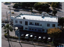
約34年もの間、徳島の港を支えてきた現庁舎
