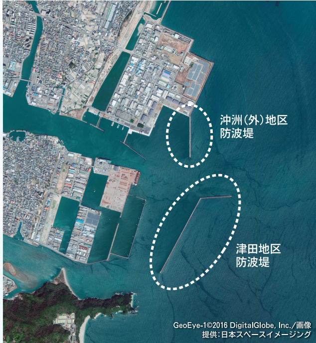
調査対象の沖洲(外)地区防波堤・津田地区防波堤の位置図
