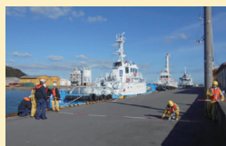
岸壁調査実施
