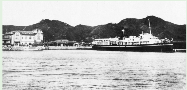
大正8年 阿摂航路の小松島港の定期船とハイカラ館 (小松島港湾・空港整備事務所 40年誌より)
