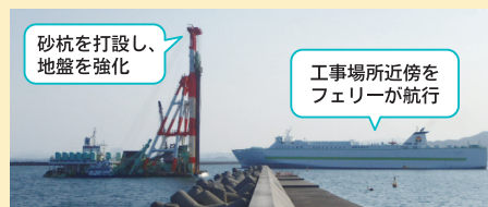
海上地盤改良（軟弱地盤の改良）
