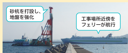
海上地盤改良（軟弱地盤の改良）
