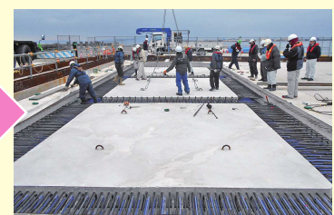
床板据付完了
