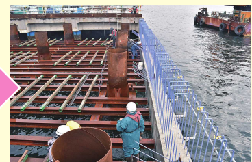
前垂れ据付完了
