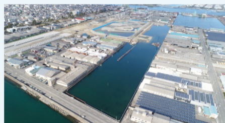
埋立工事が進む水面貯木場 （平成31年1月）
