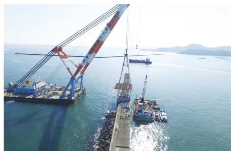
ケーソン据付け状況
