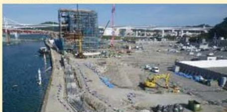
工事作業状況
