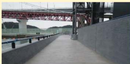
堤防の高質化
