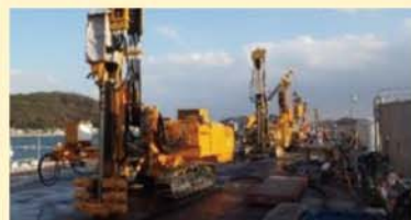
静的圧入締固め工法 作業状況
