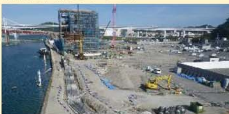
工事作業状況
