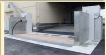
フラップゲート式陸閥(自動化陸閥)
