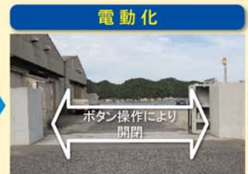
ボタン操作により開閉 電動化陸閥
