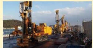
静的圧入締固め工法 作業状況
