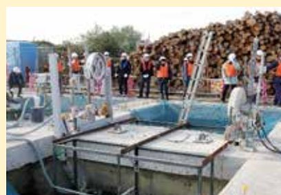
(b) 床版撤去(12月)
