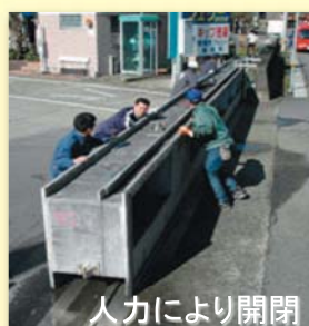
↑ 通常の陸閘(手動)
