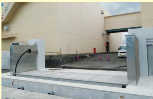
↑ フラップゲート式陸閘(通常時)
