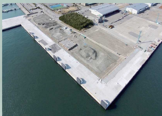
↑ 耐震強化岸壁 (平成27年3月撮影)
