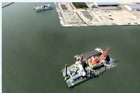
↑ 泊地、航路・泊地浚渫状況（10月）
