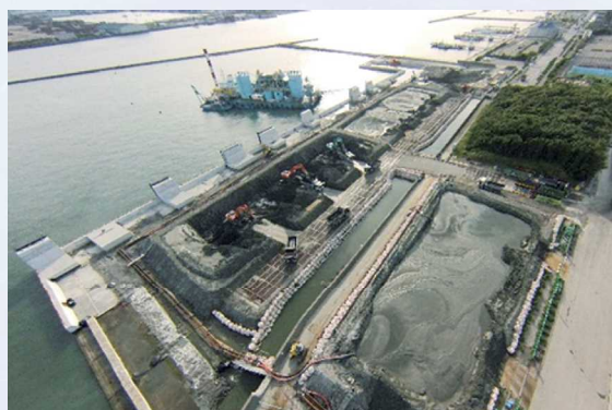
↑ 浚渫土砂改良・運搬状況（9月）
