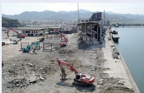
↑ 競艇場建物解体状況（7月）
