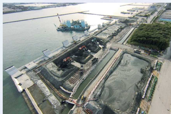
↑ 浚渫土砂改良・運搬状況（9月）
