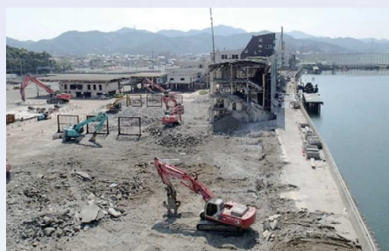
↑ 競艇場建物解体状況（7月）
