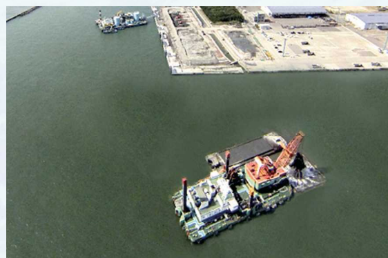
↑ 泊地、航路・泊地浚渫状況（10月）
