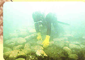
(潜水士による均し作業)
