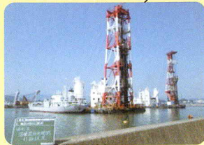
(深層混合処理船による地盤改良)
