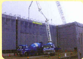
(コンクリート打設)
