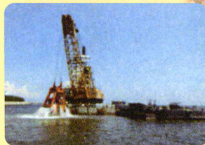
(浚渫船による作業)
