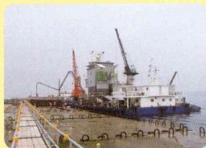
(コンクリートプラント船による打設)
