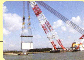
(ケーソン据付)
