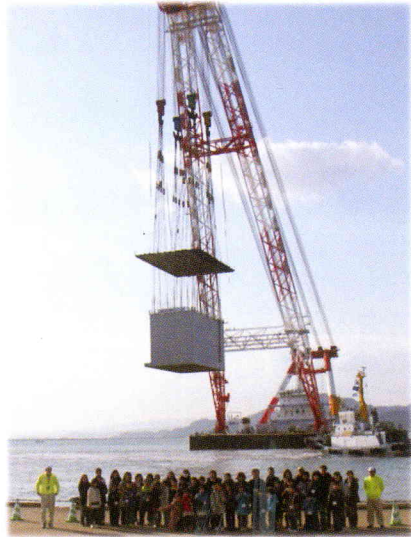
ケーソン据付見学会 (平成24年12月1日 沖洲小学校)
