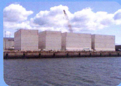
岸壁に使用する ケーソンを製作しています。
