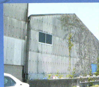
倉庫Ⅰ(平成元年築)
