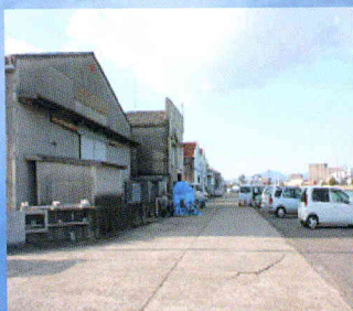
倉庫Ⅲ(昭和56年築)
