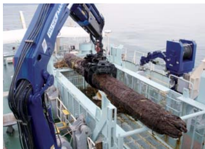
クレーンで回収した流木
