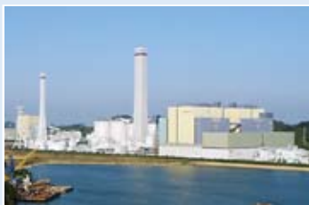
橘港に立地する石炭火力発電所
