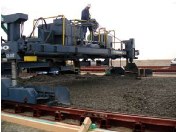
エプロン舗装工事
