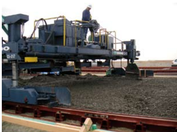
↑ エプロン舗装工事
