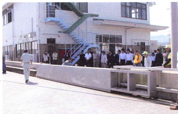
防潮扉閉鎖状況
