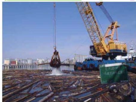
起重機船による浮遊物の撤去状況
