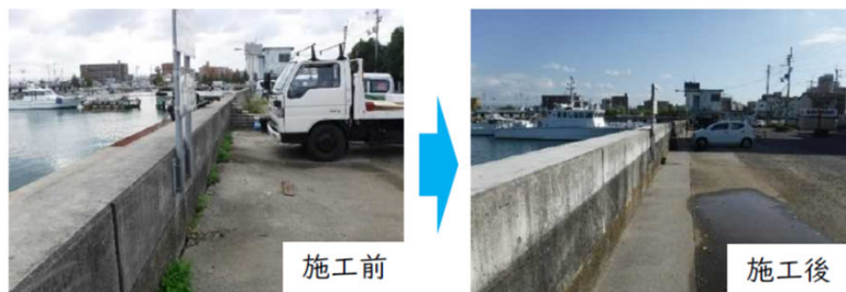
対策工事施工前後の写真
