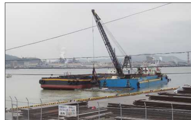
グラブ浚渫船による泊地の浚渫状況
