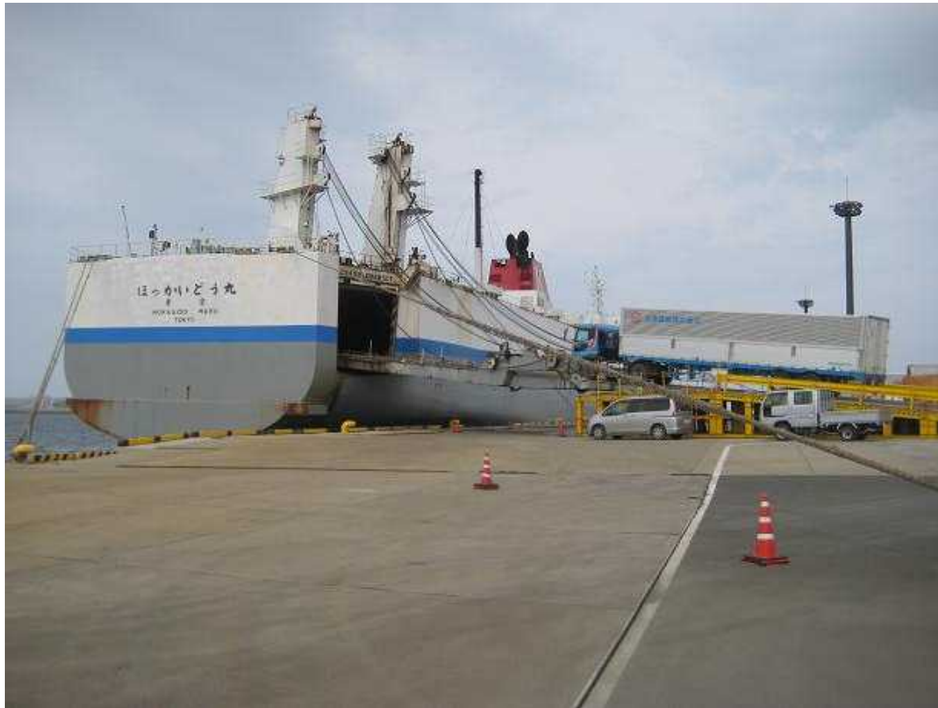
耐震強化岸壁におけるRORO船荷役の状況 (茨城港 常陸那珂港区)
