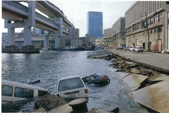
兵庫県南部地震(神戸港)
