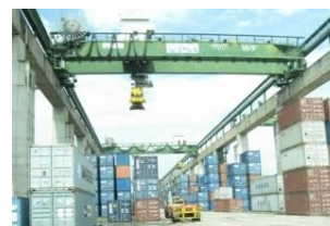
OHBC(天井クレーン)
