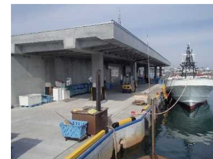
汐見地区屋根付き岸壁
