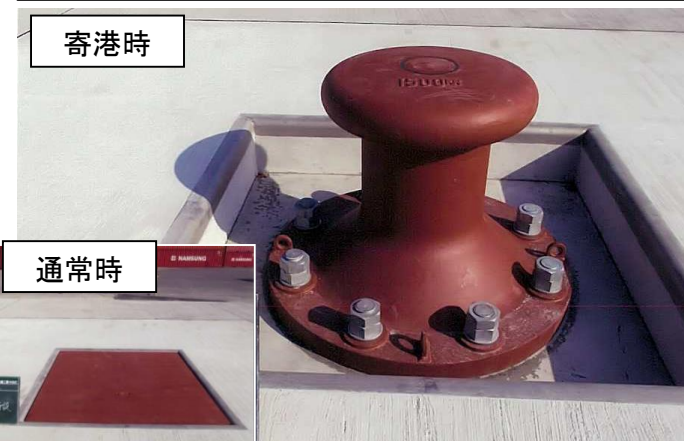
油津港の着脱式係船柱の設置
