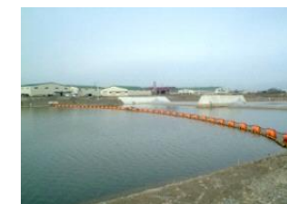
集塵用の網場の例 (ゼニヤ海洋サービス株HP より)
