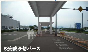
現在、工事中の歩道ルーフ（西側） 平成28年1月末頃完成予定
