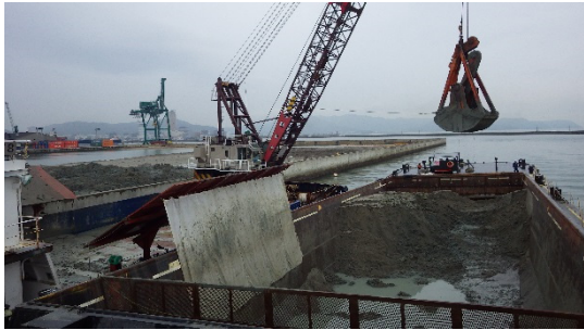
▲朝日地区への揚土状況
