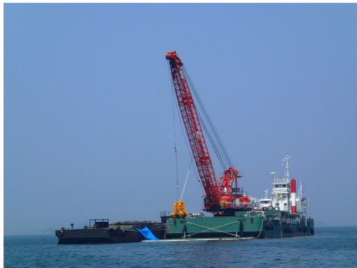
▲ 軟衝撃グラブによる浚渫(全景)
