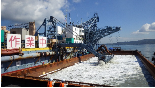
▲ポンプ浚渫状況
