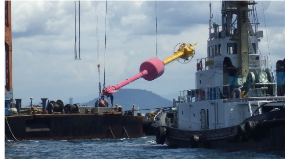
▲工事用ブイ設置状況
