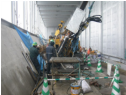
▲ 薬液を注入する削孔工事
