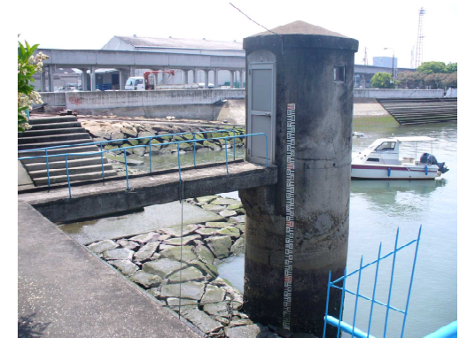
潮位計等の観測施設の設置
