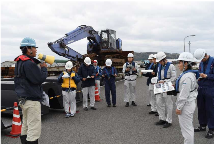
大型クруз船が利用する岸壁の工事見学
